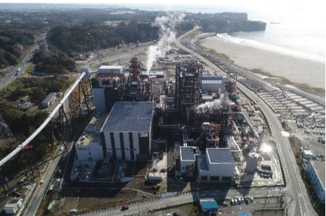
勿来IGCC発電所（54.3万kW機） 三菱パワー株式会社提供
