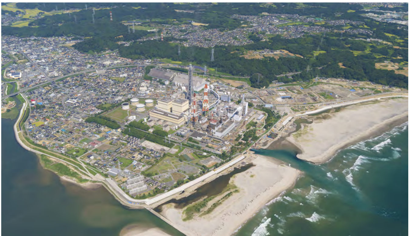
勿来発電所全景 (上空より)
