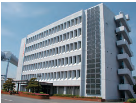
勿来発電所サービスビル太陽光発電設備
