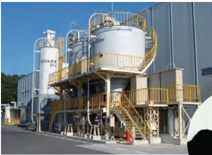
炭化燃料設備
