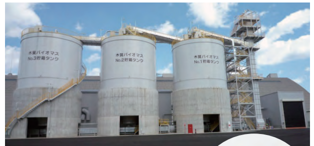
木質バイオマス燃料設備
