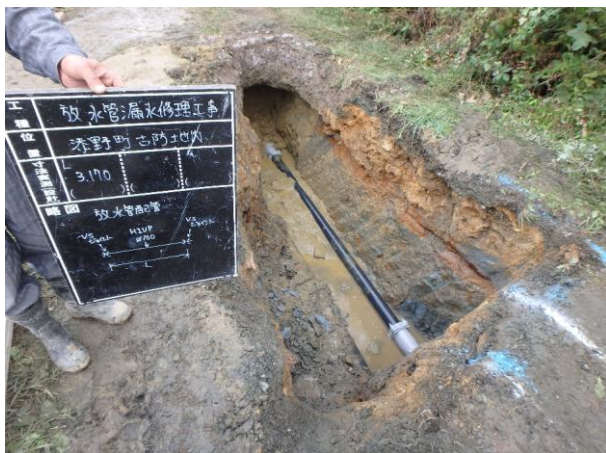
漏水箇所配管替え状況
