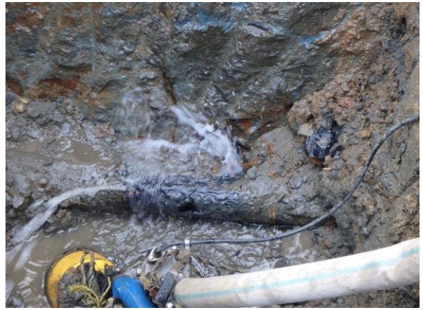
漏水箇所状況
