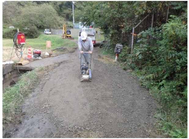
埋戻し転圧状況
