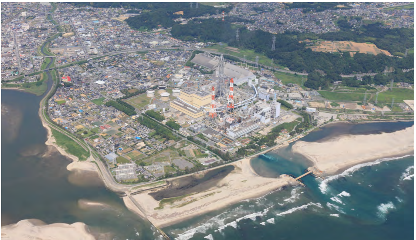
勿来発電所全景(上空より)
