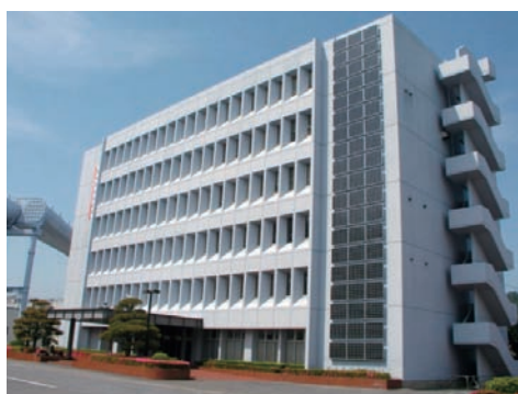
勿来発電所サービスビル太陽光発電設備
